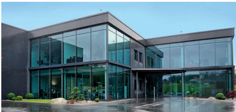
Das neue Firmengebäude. Das Haus bezieht seine Energie aus einer passiven, ressourcenschonenden Quelle: Erdwärme. Im Sommer werden die Büros mit ihr gekühlt, im Winter geheizt.
